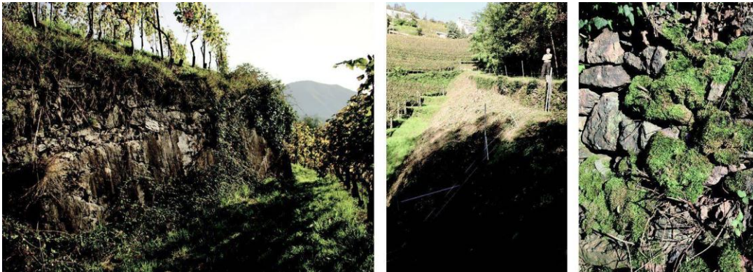
La roccia di Nava (a sinistra) e l'argine di Costera, così come un dettaglio del muro a secco.
